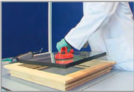
L'unité de double vitrage est positionnée dans le cadre
