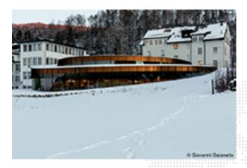
Cette réalisation repoussant à l'extrême les limites technologiques du vitrage structurel concentre ici 101 éléments de murs-rideaux courbes et trapézoïdaux supportant intégralement les charges de la façade en l'absence d'appuis supplémentaires. Les vitrages isolants sont ainsi collés haut et bas à l'intérieur de modules en acier spécialement fabriqués pour l'occasion, un mortier d'injection évitant tout contact entre le warm edge et l'acier.
